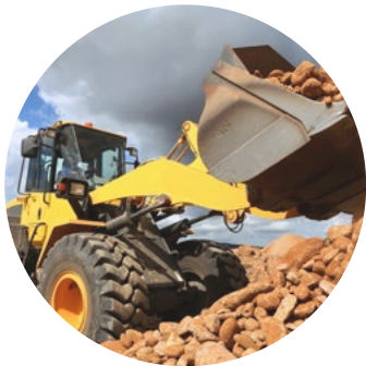
Construcción y Demolición
